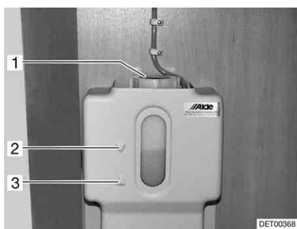
Fig. 258 Vaso d'espansione con diaframma
