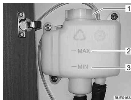
Fig. 259 Vaso d'espansione senza diaframma
